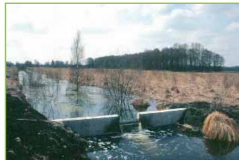
Zur Probe: Aufstau eines Grabens
