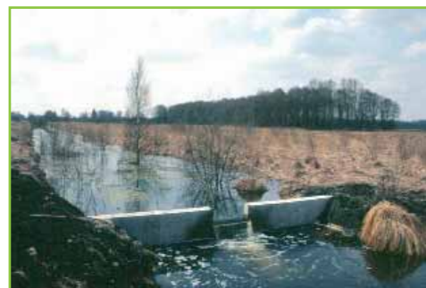
Zur Probe: Aufstau eines Grabens
